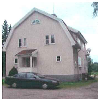
putsad byggnad intill Ekängsvägen
